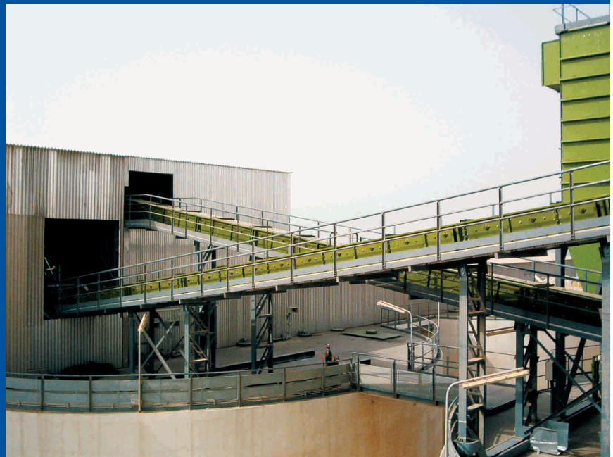
Bahrain - Impianto di calcinazione coke di petrolio Bahrain - Coke calcining plant
